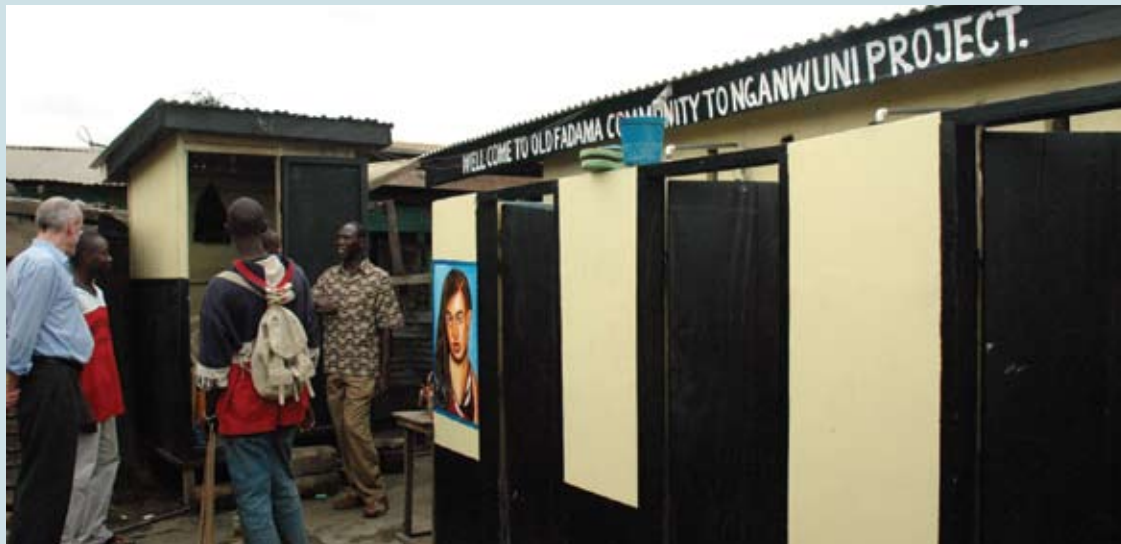
ONU-HÁBITAT área de enfoque: Infraestructura y servicios urbanos básicos Ecológicamente racionales- un nuevo bloque de ducha para hombres y mujeres con agua limpia en un barrio bajo en Ghana.
