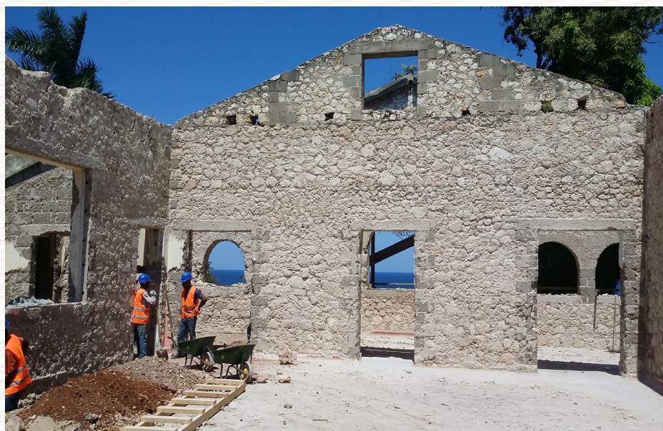
Photo 2 : Réhabilitation par le Projet de la bibliothèque municipale de Jérémie, mars 2020.
