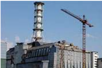
La centrale nucléaire de Tchernobyl.
