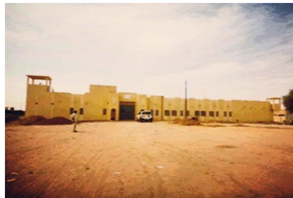
La Maison d'Arrêt et de Correction de Gao, Mali, après rénovation, juillet 2014.
