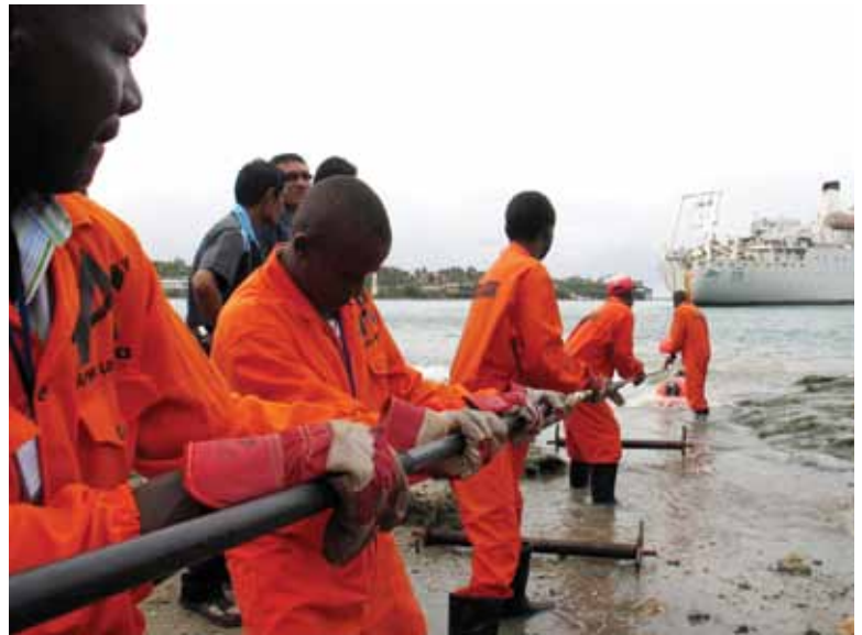
Installation de câbles en fibre optique au large de la côte de l'Afrique de l'Est: Plus de PMA auront des liens de communication avec l'extérieur plus rapides et moins chers. Photo: Reuters/Joseph Okanga
