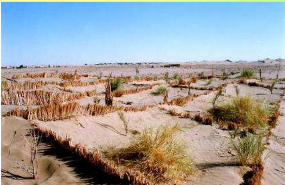
**Закрепление подвижных песков производится с установкой механической защиты и посадкой псаммофитов**
