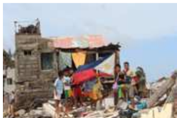
Dégâts causés par le typhon Haiyan aux Philippines. Photo: OCHA/Akiko Yoshida
