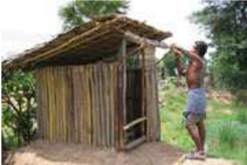
Construction de sanitaires au Cambodge.
