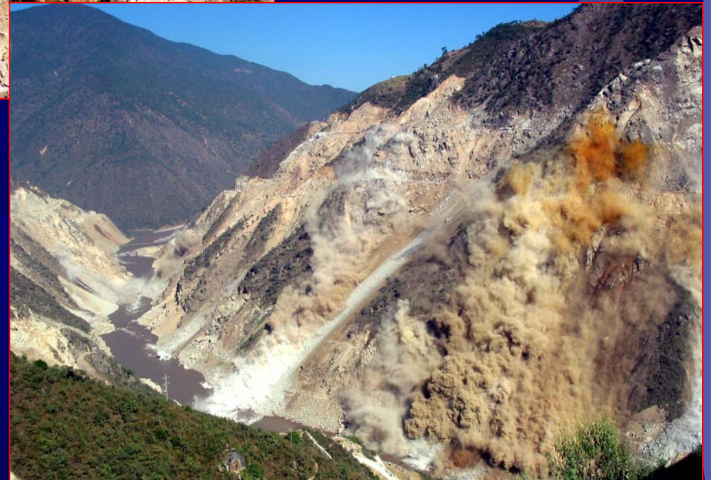
✦ 高边坡爆破照片
