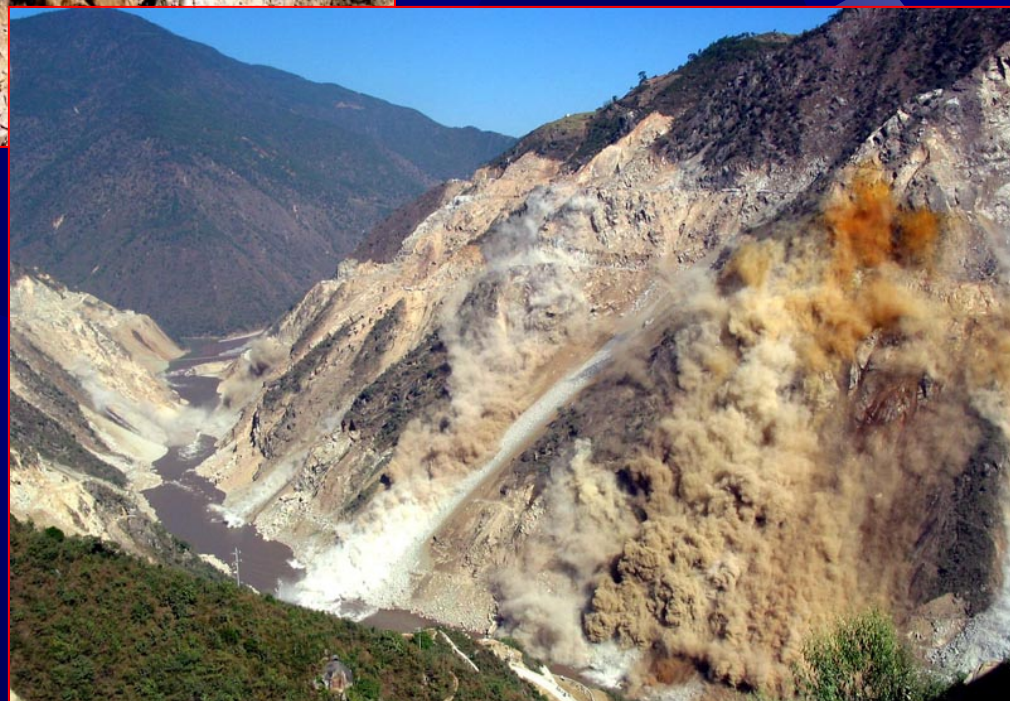
✿ 高边坡爆破照片
