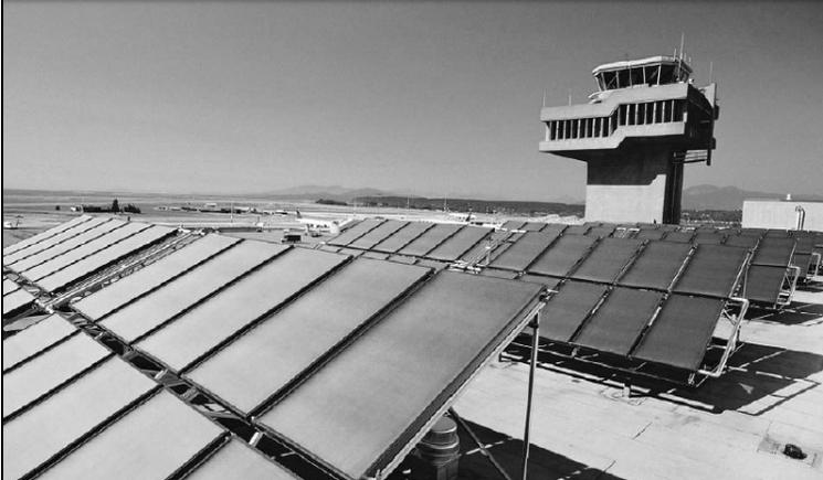
100 capteurs solaires avec vitrage près de la tour de contrôle
