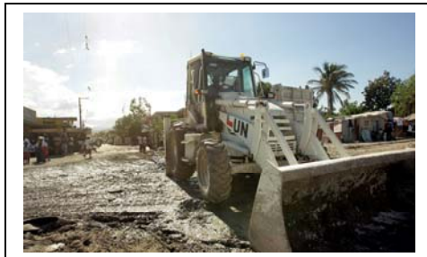
Travaux de génie civil à Carrefour par les Chiliens
