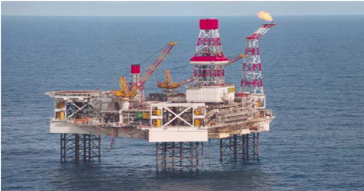
Figure 7. Plate-forme fixe autoélevatrice de production Harding (Achevée en 1996) (Technip)
