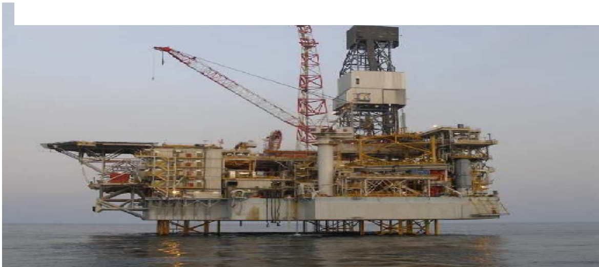
Figure 8. Plate-forme fixe autoélevatrice de production BP SHAH DENIZ (Achevée en 2006) (Technip)
